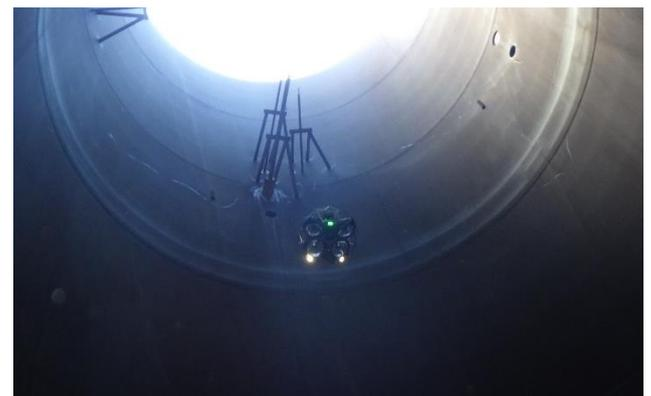
火力発電所の煙突内部を点検する ELIOS 3
